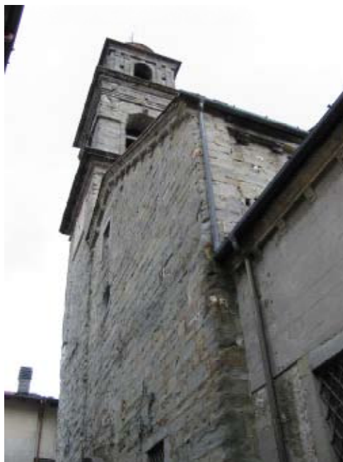
13. San Marcello, antica facciata con il campanile settecentesco.
