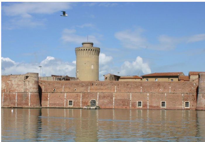
Fortezza Vecchia, primo piano con "Mastio di Matilde".
