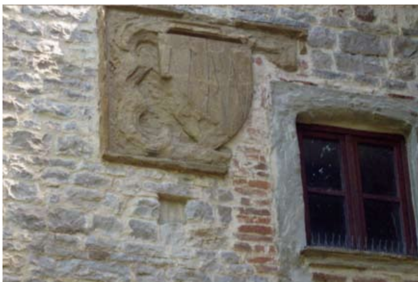
Acciaiolo: lo stemma dei Davizi spezzato per aprire una finestrella sopra l'ingresso posteriore (ripresa ravvicinata).
