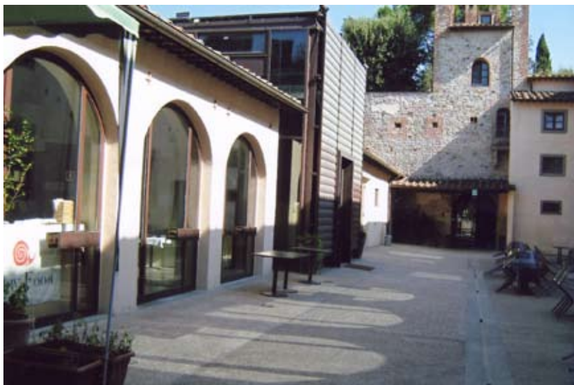
Acciaiole: cortile interno dopo il restauro.
