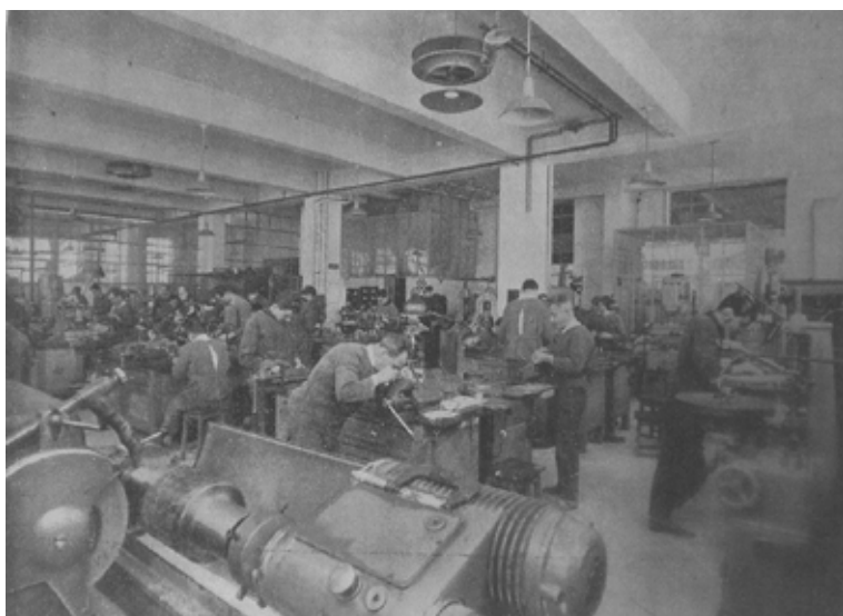
Operai all'interno della Uno A Erre
