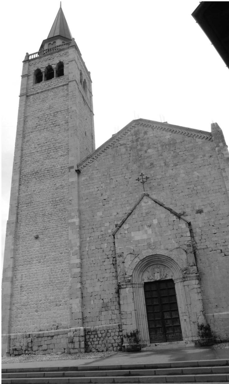
Fig. 28 – La facciata del Duomo di Venzone, ampiamente ricostruita in “forme semplificate” a seguito dei gravissimi danni del terremoto del 1976 [Sebi1, wikimedia.commons, pubblico dominio]
