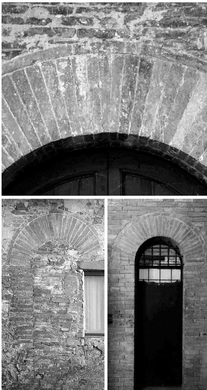
Fig. A7 – Dettaglio della ghiera del portale trecentesco che dà accesso alle cantine della Grancia di Montisi. La tecnica dei conci laterizi sagomati a cuneo, assai raffinata è di antica origine romana e diffusa nei più importanti cantieri senesi trecenteschi. Arco a cunei rastremati nel Cortile del Podestà, Palazzo Pubblico di Siena; monofora ad arco a cunei rastremati all'ultimo piano della Grancia [©imprintedsigns.com]
