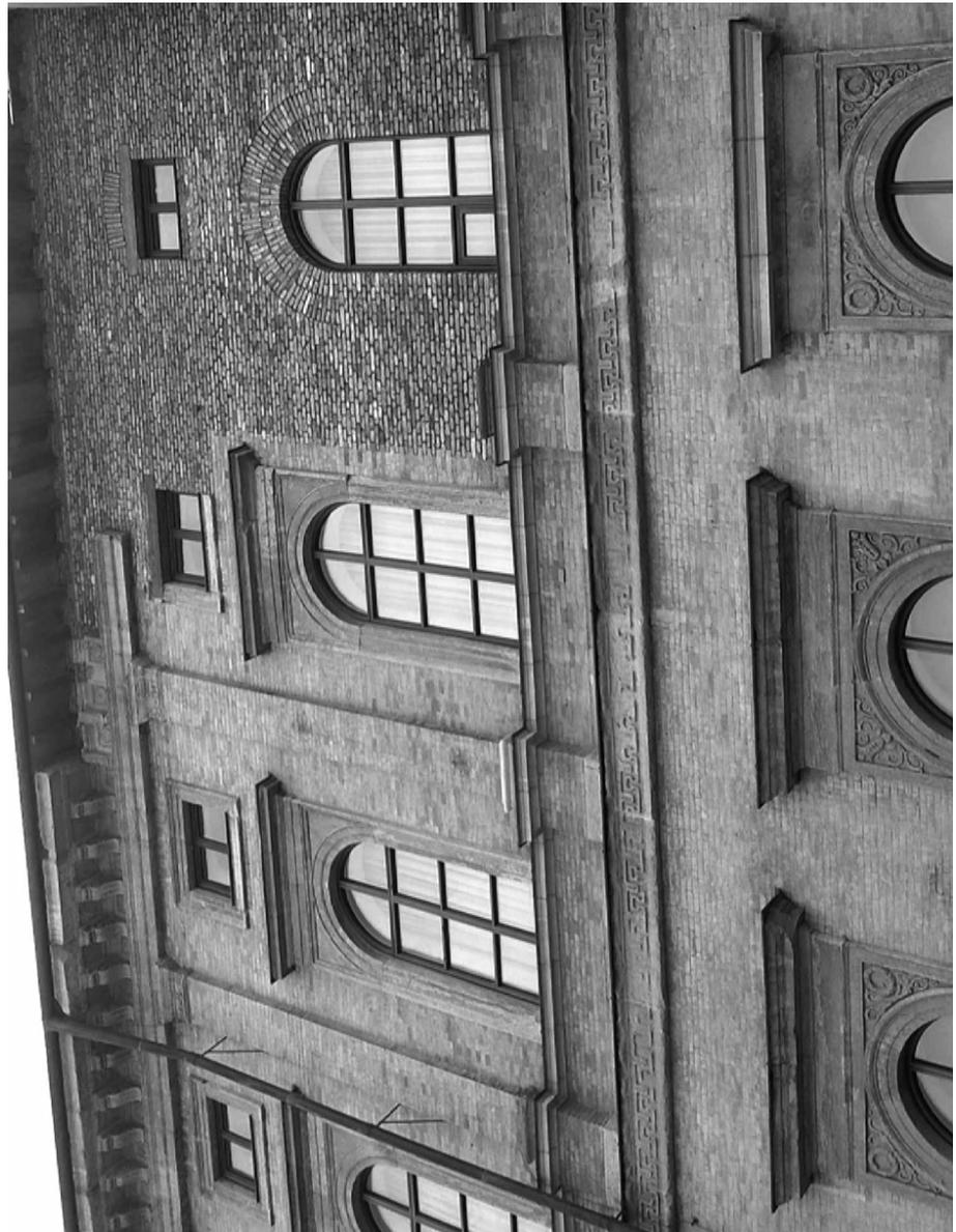
Fig. 30 – Monaco di Baviera, la *wiederaufbau* dell'Alte Pinakothek su progetto di H. Döllgast [foto dell'A., 2015]
