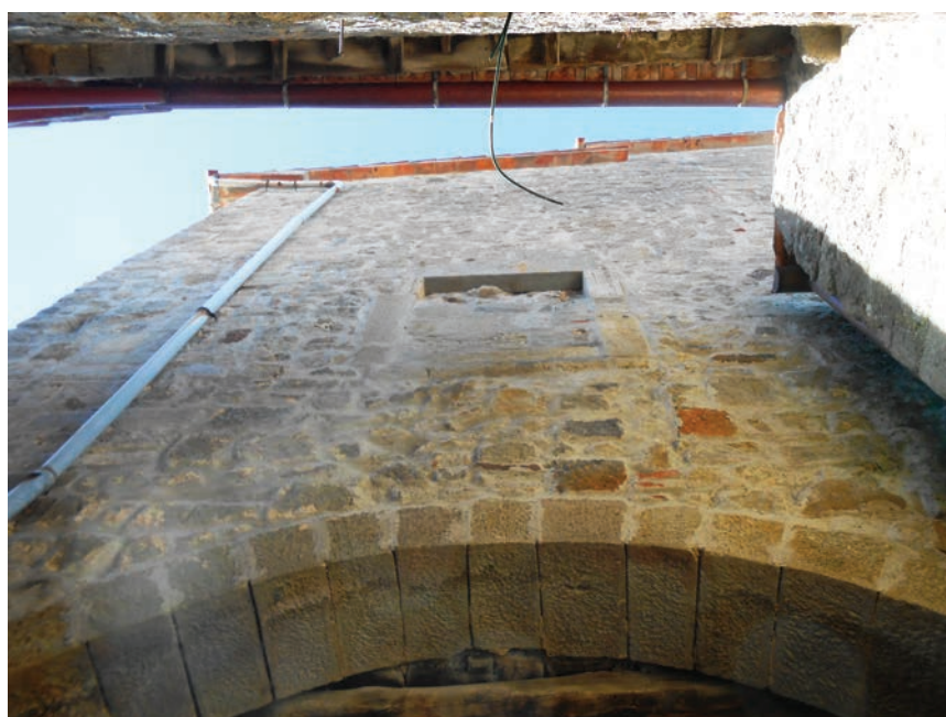
Fig. 11. Il passaggio dalla prima loggia alla seconda loggia, con il prospetto dell'unità edilizia limitrofa, con una finestra tamponata, Santa Fiora.
