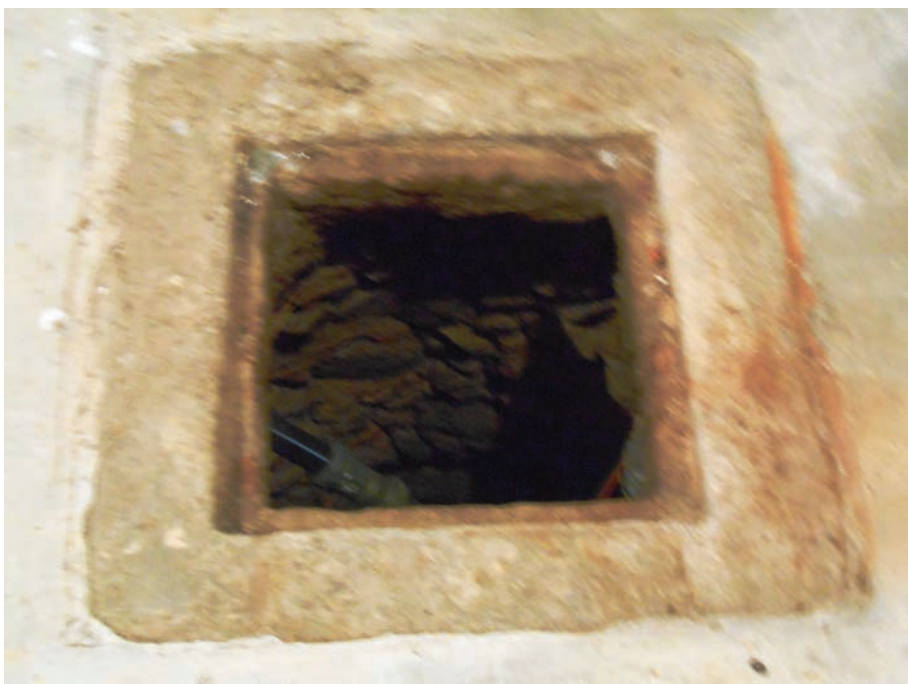
Fig. 29. L'apertura sul pozzo, scavato nella roccia, Santa Fiora.
