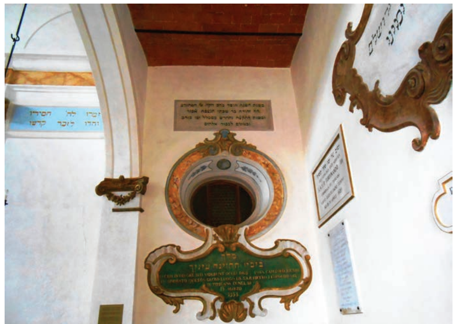
Fig. 8. La sinagoga di Pitigliano, veduta dell'ingresso.
