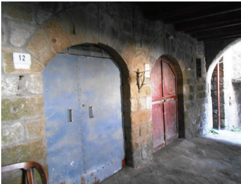
Fig. 16. Le due porte sulla parete settentrionale della seconda loggia, dotate di ghiera da arco acuto analoga a quella della facciata del palazzo del podestà, Santa Fiora.
