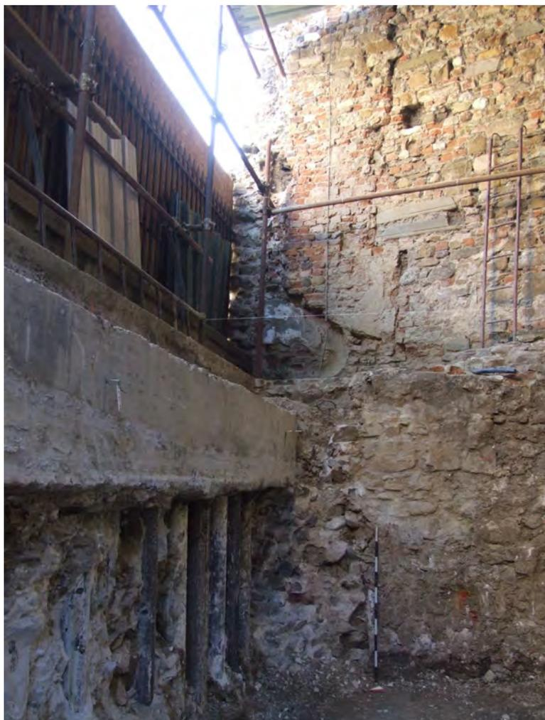
Fig. 4a. Cappelle Medicee. Lesione strutturale sulla muratura dell'angolata N della Sagrestia Nuova della Basilica. In basso, contatto tra opera di fondazione delle mura cittadine e fondazioni della Basilica
