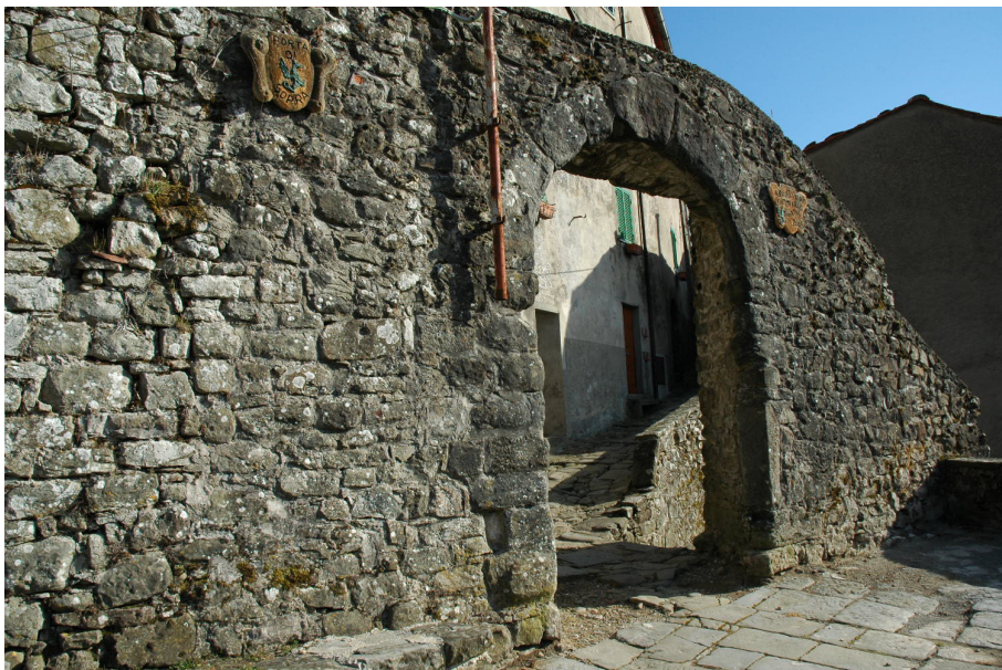
Foto 236 Porta di sopra e mura di Pontito
