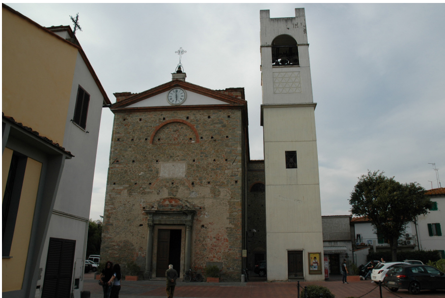
Foto 40 Chiesa di S. Maria della Neve a Chiesina Uzzanese
