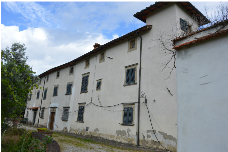
Foto 59 Villa Manni a Carraia
